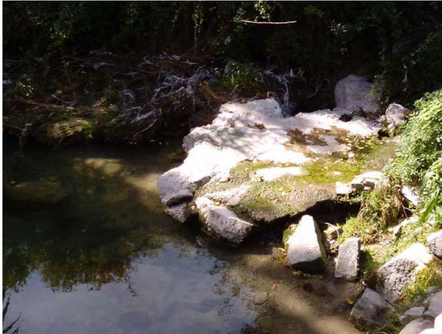
Formigó a la base de la sortida del sobreexidor
